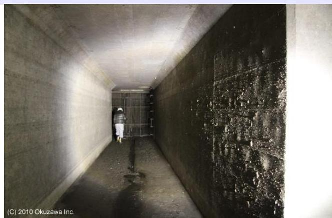
◀ 一時的に溜めた雨水は、自然に下水道管に戻っていく仕組みになっています。最後まで残った雨水はこの道を通してポンプでくみ上げ排水されます。
