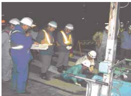
写真4-2 他企業工事の立会い
