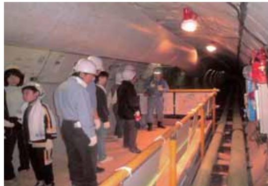
写真4-4 工事現場見学会
