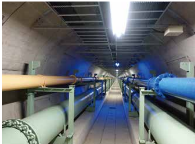
北多摩一号水再生センター・南多摩水再生センター連絡管
