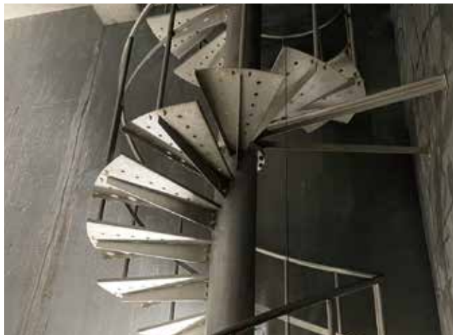
渋谷雨水貯留施設
