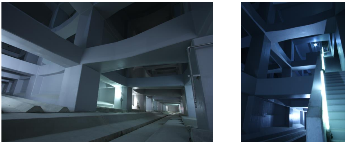
図5 業務・商業ビルの地下に位置する76,000m 3 の雨天時貯留池
