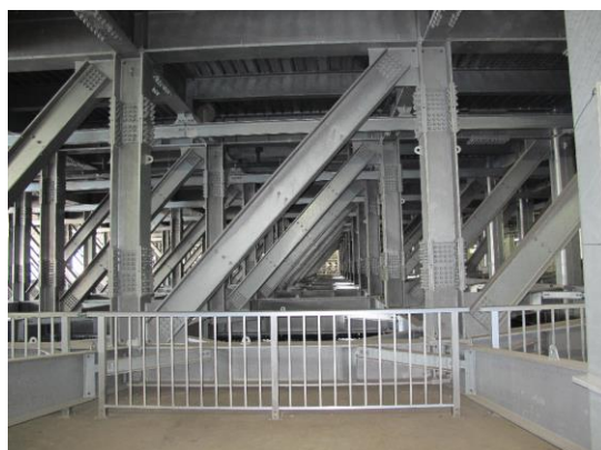
図 4 メガトラス構造の人工地盤
