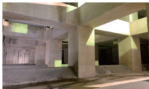
▲南砂雨水調整池。25mプール約80ばい分の雨水をためることができる。
