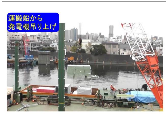
図4 クレーン台船による発電機搬入の様子
