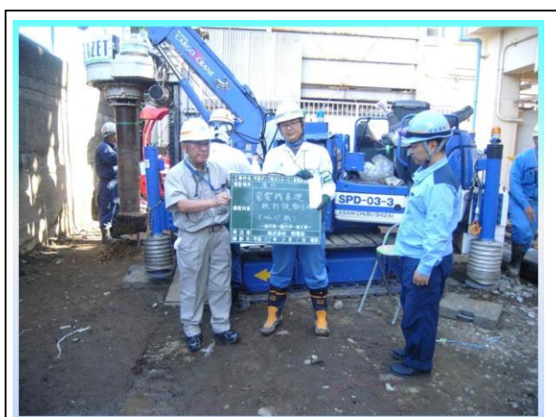
図9 杭打ち施工現場①
