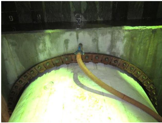
写真 2.5 地下水調査状況
