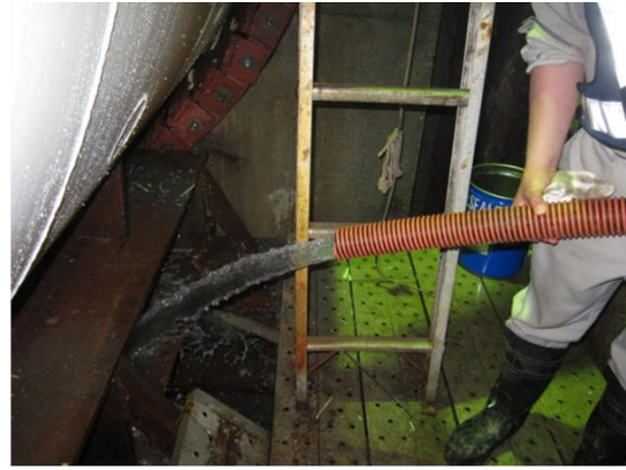
写真 2.6 地下水調査状況
