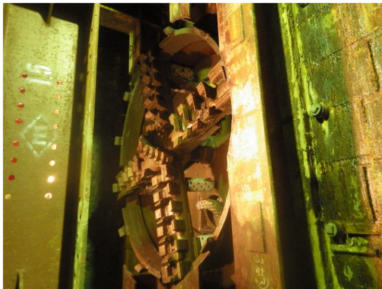
写真 5.1 シールドマシン到達状況 (H27.9)
