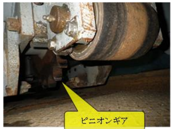
写真 4.3 ピニオンギア設置状況
