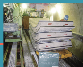
コンクリートのブロックを機械で組み立てて、下水道管の形にしていきます。
