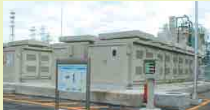
▲砂町水再生センターのNaS電池
