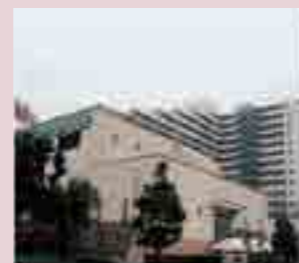
▲南砂雨水調整池外観
