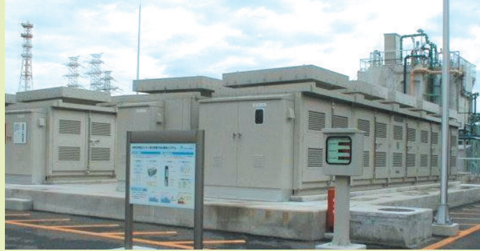
▲ 砂町水再生中心的NaS电池
