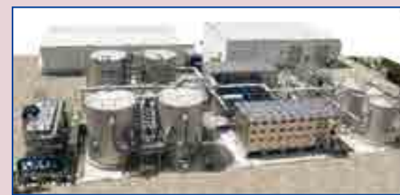
セラミック膜ろ過による再生水製造施設
