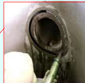
下水道管とマンホールの 接続部を対策する様子
