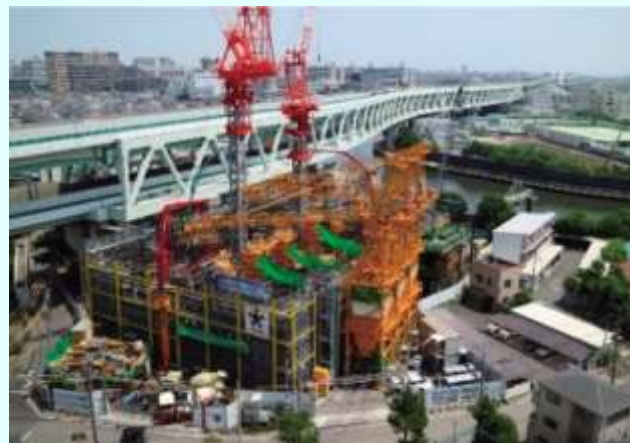
王子第二ポンプ所 (整備中)
