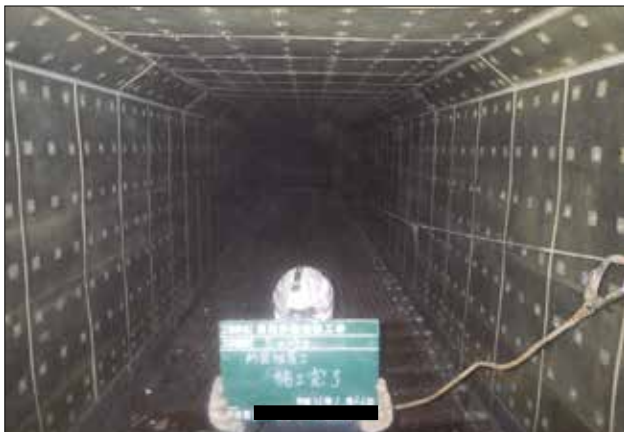
図 17 防食被覆工完了
