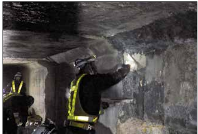
図 16 断面修復工（超速硬モルタル）
