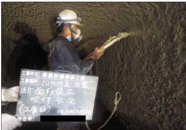
図 15 断面修復工（セメントモルタル）
