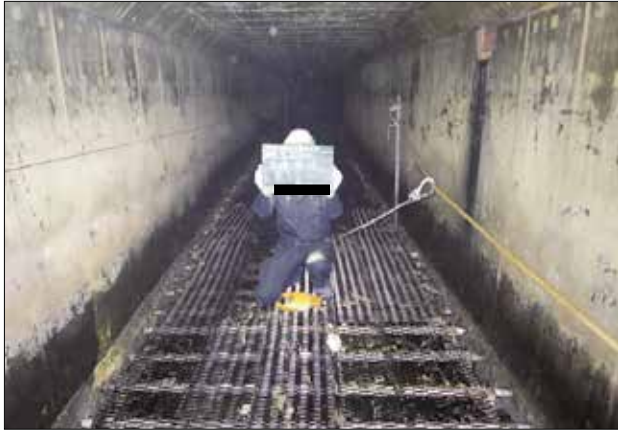
図 13 足場仮設完了
