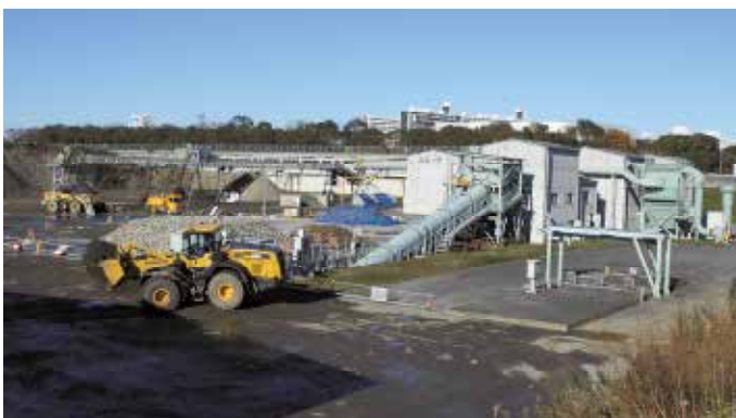
写真-2 中川建設発生土改良プラント
