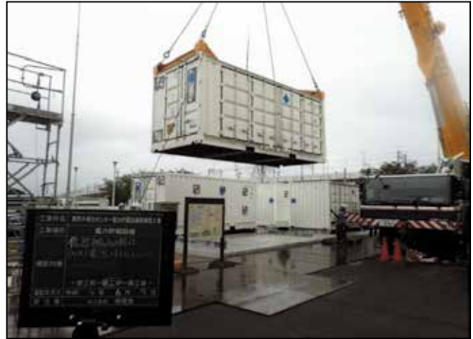
図 5 新設コンテナ型 Na S 電池据付け作業
