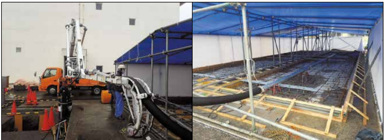
図7 仮設屋根設営状況
