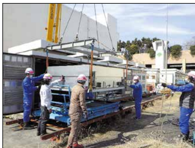
図4 既設パッケージ型NaS電池施工状況
