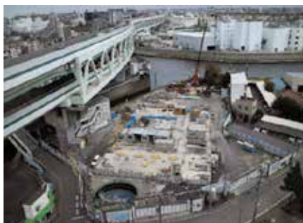
図3 施工状況(全景)
