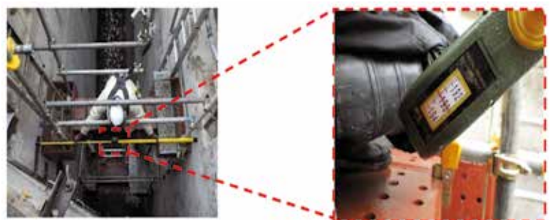
図 23 ケーソン間の離隔 測定状況
