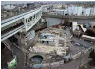
写真1 施工状況(全景)
