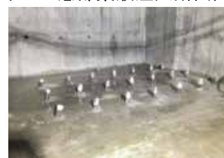
写真2 薬液注入箇所(口元管)
