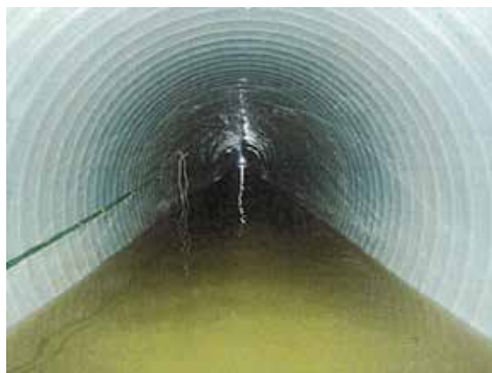
図8 施工後の幹線内写真
