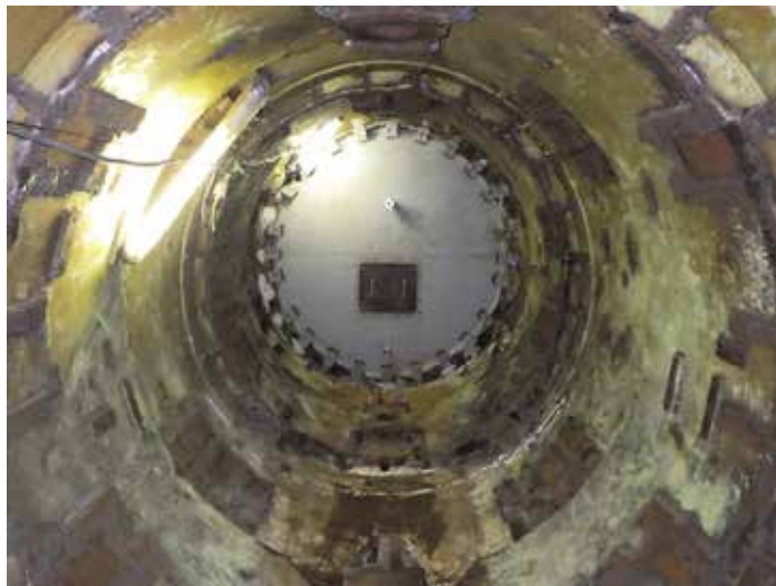
図6 発進立坑側からの仮壁設置状況
