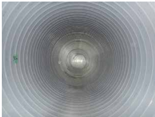
図 12 施工後の大手町幹線
