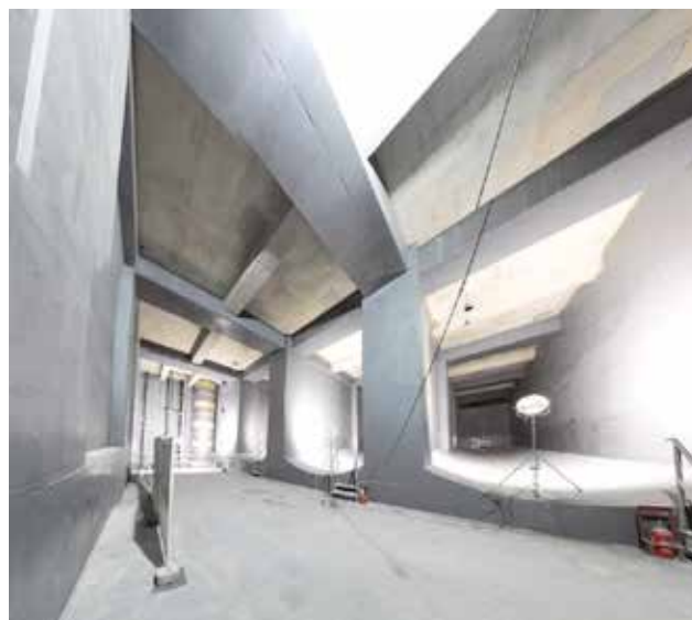
図6 雨水貯留施設内部
