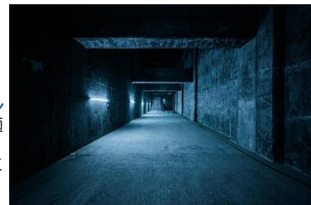
▲施工中の王子第二ポンプ所貯留施設 (今後稼働に必要な施設を整備予定)
