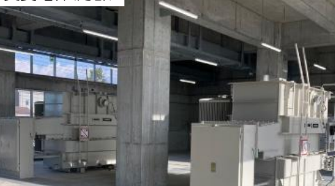
▲立川市単独処理区の流域下水道の編入に向け、受変電設備の再構築を実施（北多摩二号水再生センター） ▶関連 38ページ
