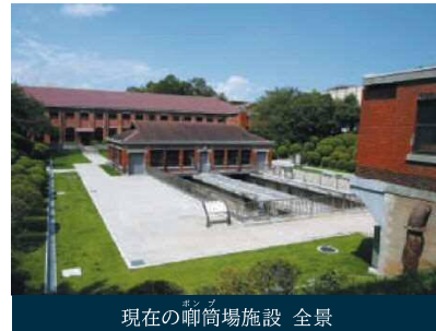
現在のポンプ場施設 全景
